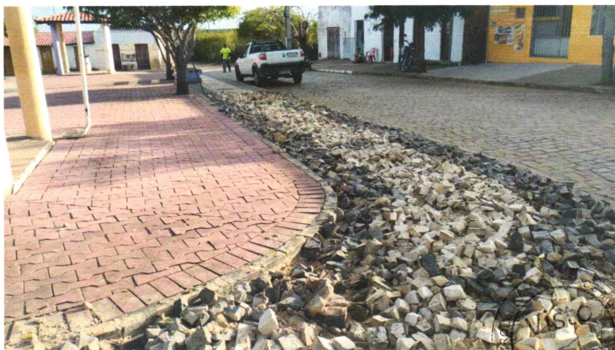
Foto 08 – Remoção de piso em Pedra Portuguesa
