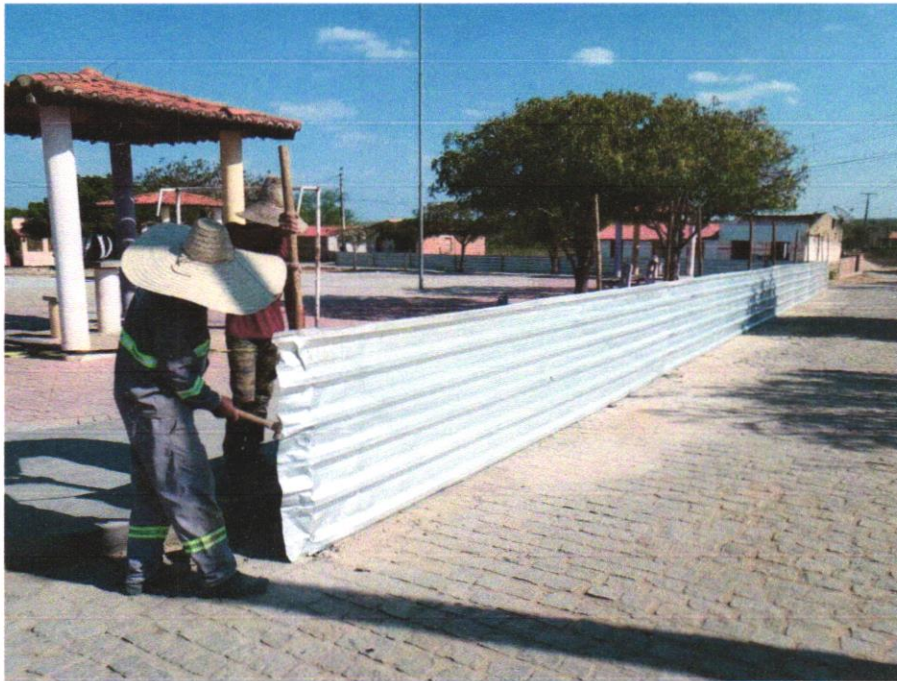
Foto 01 - TAPUME COM TELHA METÁLICA. AF_05/2018
