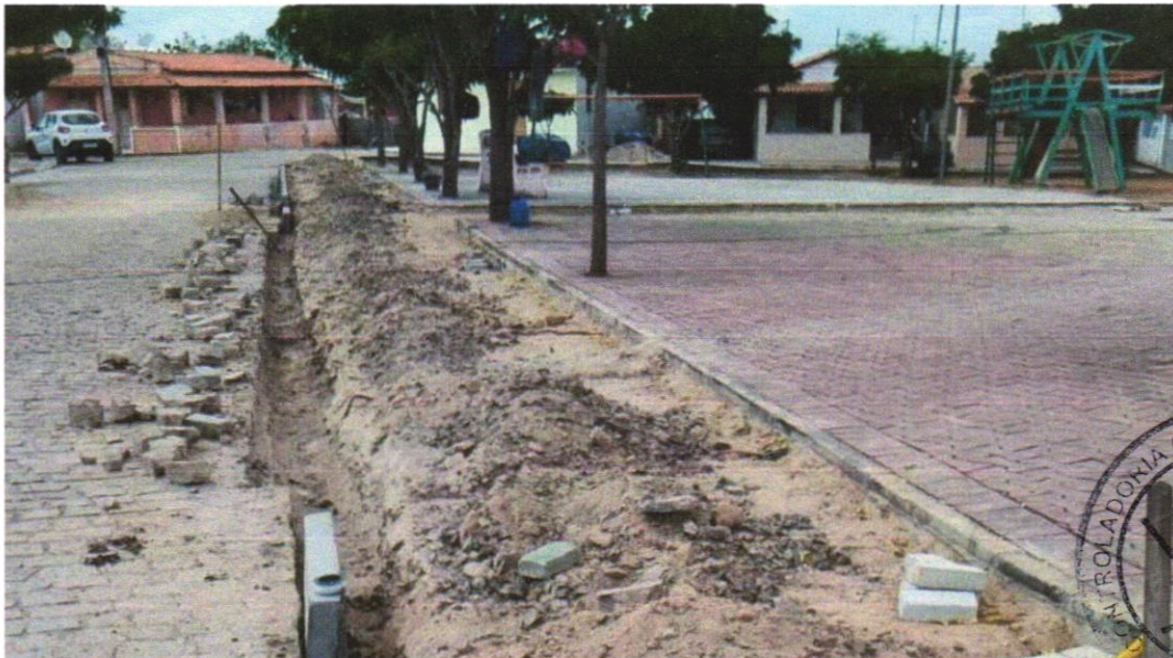
Foto 02 – RETIRADA DE MEIO-FIO DNER / ECONOMICO COM EMPILHAMENTO E SEM BOTA FORA
