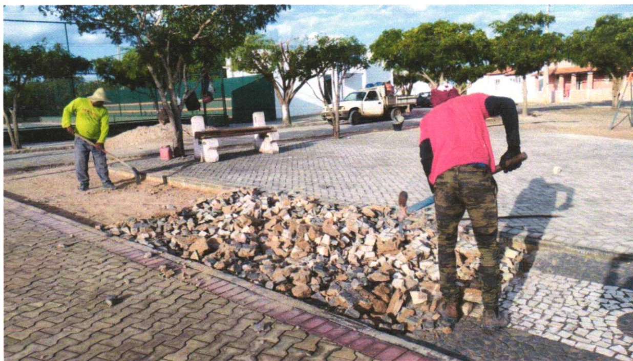
Foto 07 - Remoção de piso em Pedra Portuguesa
